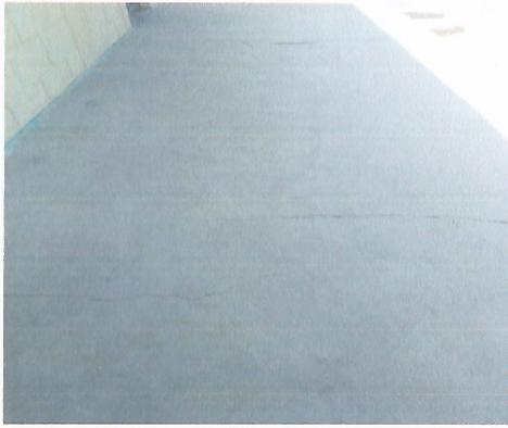
Foto 1: Colocación de piso cerámico anti deslizante en corredor anexo 2
